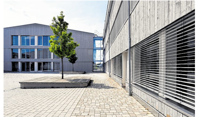
Das Schmuttertal-Gymnasium in Diedorf wurde für seine energieeffiziente Bauweise mit Holz mehrfach ausgezeichnet. Foto: Marcus Merk
