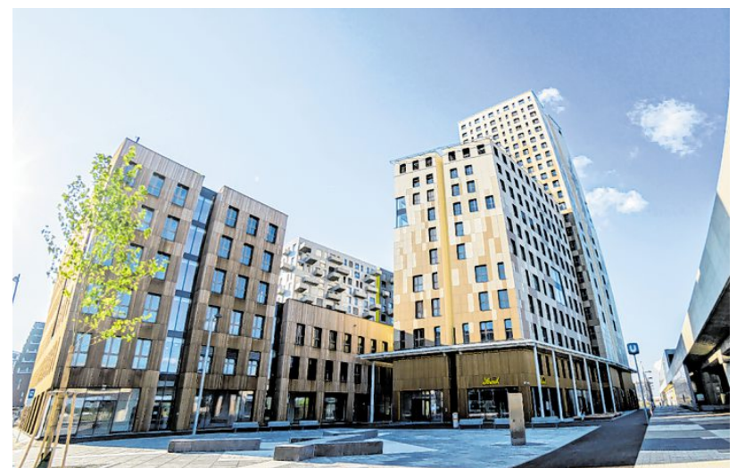
Das Hotel HoHo in Wien gehört zu den höchsten Holzhochhäusern der Welt. Dieses Beispiel zeigt, wie vielfältig der Baustoff Holz ist. Foto: MysteryShot, stock.adobe.com
