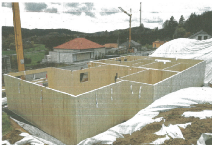
Fast im Handumdrehen: Der Holz Keller steht innerhalb nur eines Tages und ist sofort beziehbar.
